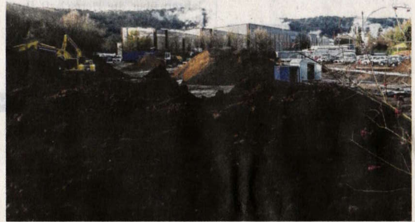
Der Untermaubacher Standort der Firma „Metsä Tissue“ wird um eine Lagerhalle erweitert. Foto: smb
